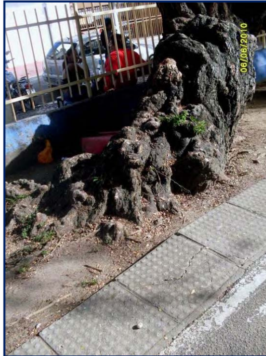
Figura 45. Raiz da Pithecellobium dulce (Acácia-mimosa) causando danos no sistema de circulação do Parque - 13 de Maio, Recife – PE. Fonte: arquivo do autor, 2010.
