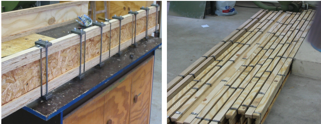
FIGURA 10 – PRENSAGEM E AMARRAÇÃO DAS VIGAS
