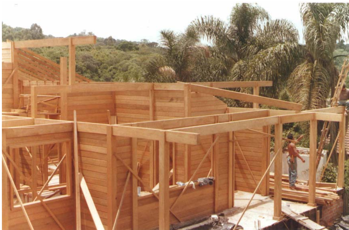
FIGURA 17-SISTEMA VIGA PILAR- MONTAGEM DAS VIGAS
