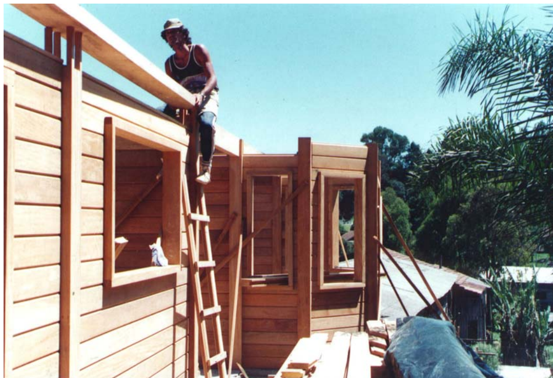
FIGURA 17-SISTEMA VIGA PILAR- MONTAGEM DAS VIGAS
