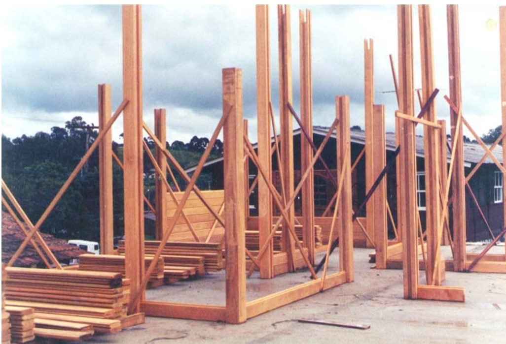
FIGURA 15 – SISTEMA VIGA- PILAR- MONTAGEM/ PILARES
