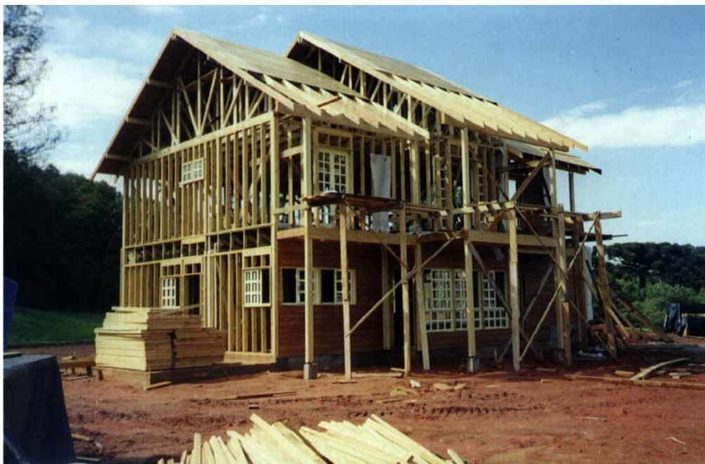
FIGURA18- SISTEMA CONSTRUTIVO TIPO PLATAFORMA OSSATURA
