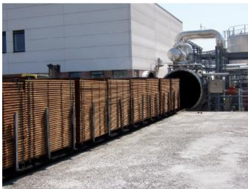
FIGURA 1.5 - REATOR UTILIZADO PARA O ESTÁGIO DE TERMOHIDRÓLISE DO PROCESSO Plato ®
