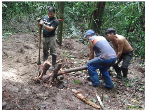
Figura 13 - O solo arenoso permitiu a retirada de raízes com o método de “alavanca”
