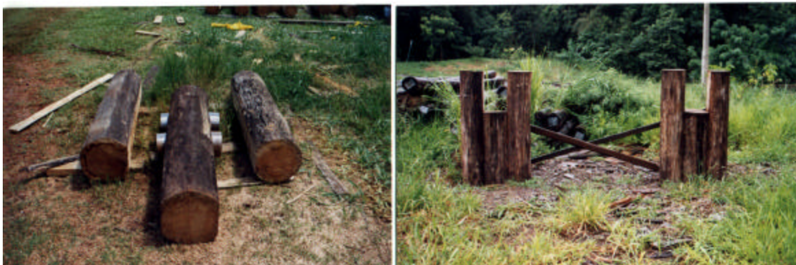
Figura 32 - Garfos de madeira para apoio das vigas bicirculares no contexto da paisagem rural.
