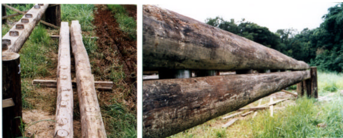
Figura 37 - Posicionamento dos anéis (a) e justaposição final dos postes constituintes da viga bi-circular (b).
