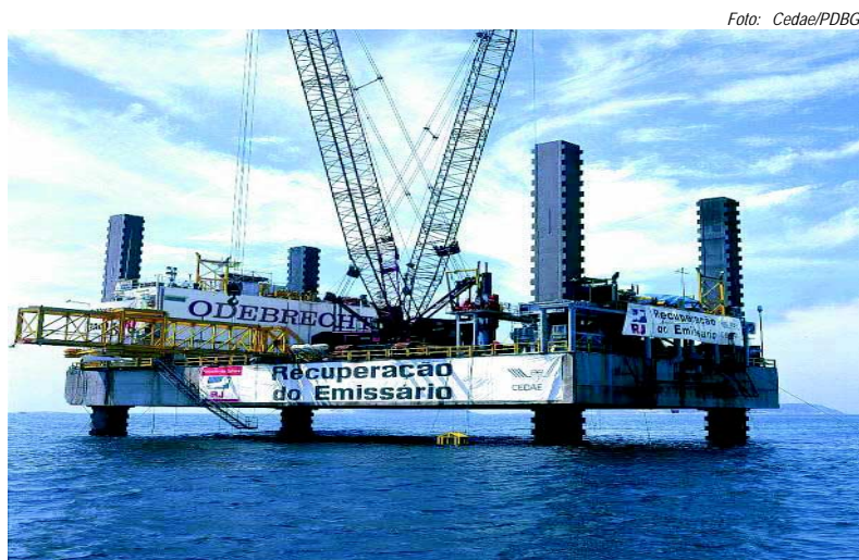
Recuperação do emissário submarino de Ipanema ocorre após 25 anos de operação
