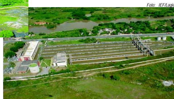
A Estação do Guandu trata 45m 3 /s de água, que passa a ser potável
