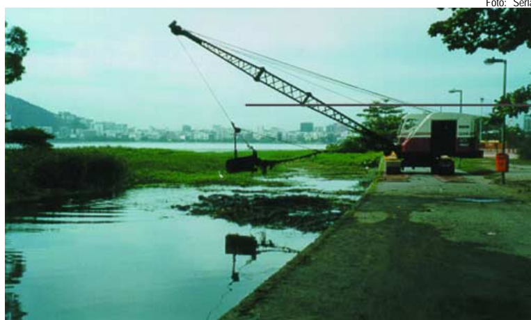
A manutenção (limpeza e dragagem) da lagoa Rodrigo de Freitas tem sido realizada periodicamente, como se vê junto ao Clube Naval (Av. Borges de Medeiros)
