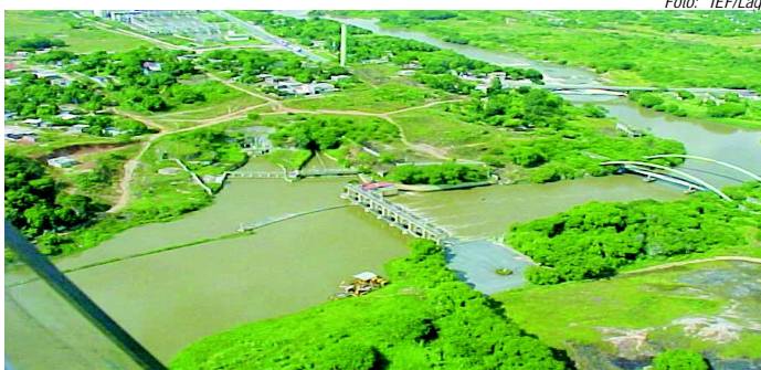
Barragem de captação no rio Guandu
