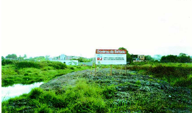
Vala sete no bairro Arcampo...
