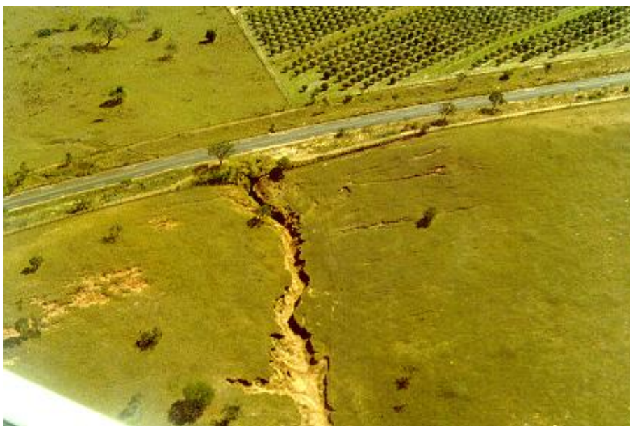
Figura 84 – Voçoroca proveniente da erosão hídrica na malha viária.
