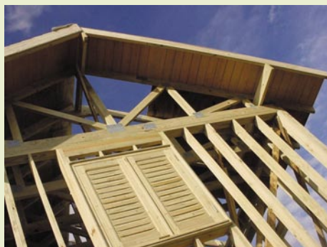
Detalhes de uma construção feita em sistema leve em madeira
