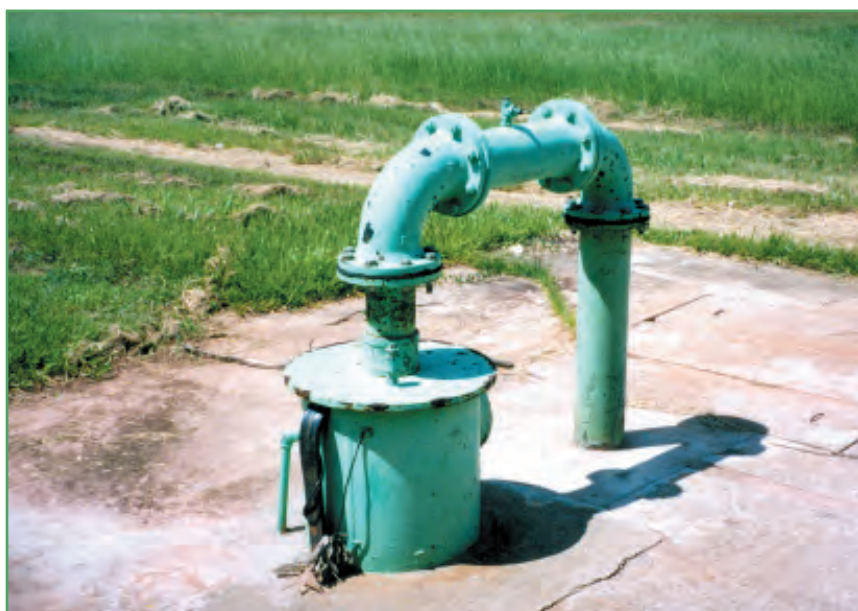
Foto 20 - Poço tubular explotando água do Aquífero Guarani, em sua porção confinada – Presidente Prudente, SP
