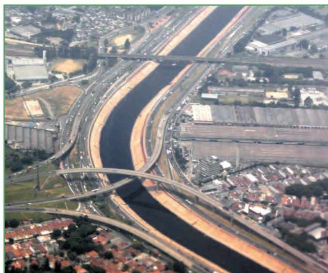
Foto 8 - Vista aérea do rio Tietê, com a via Marginal Tietê e o início da rodovia dos Bandeirantes, após obras de desassoreamento e aprofundamento da calha
