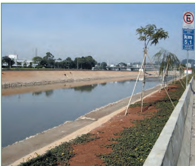
Foto 7 - Vista do rio Tietê, a partir da via Marginal Tietê, após obras de desassoreamento e aprofundamento da calha
