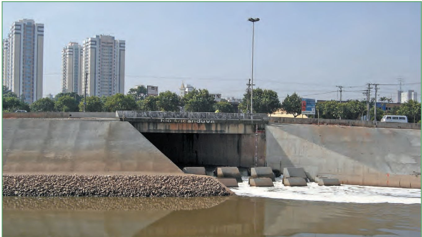
Foto 11 - Vista do deságüe do rio Aricanduva no rio Tietê, nas proximidades da via Marginal Tietê, em São Paulo, SP – situação após obras de desassoreamento e aprofundamento da calha. Notar espuma.
