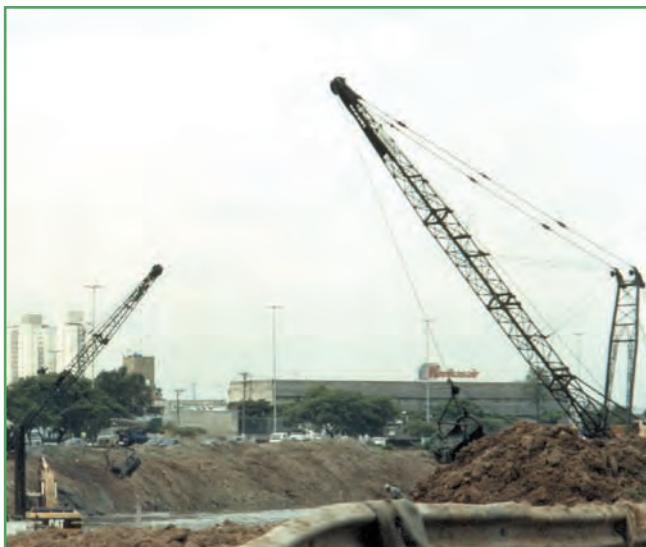
Foto 5 - Obras de desassoreamento e aprofundamento da calha do rio Tietê
