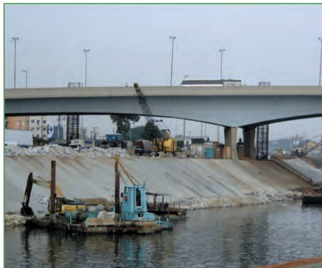
Foto 6 - Obras de desassoreamento e aprofundamento da calha do rio Tietê
