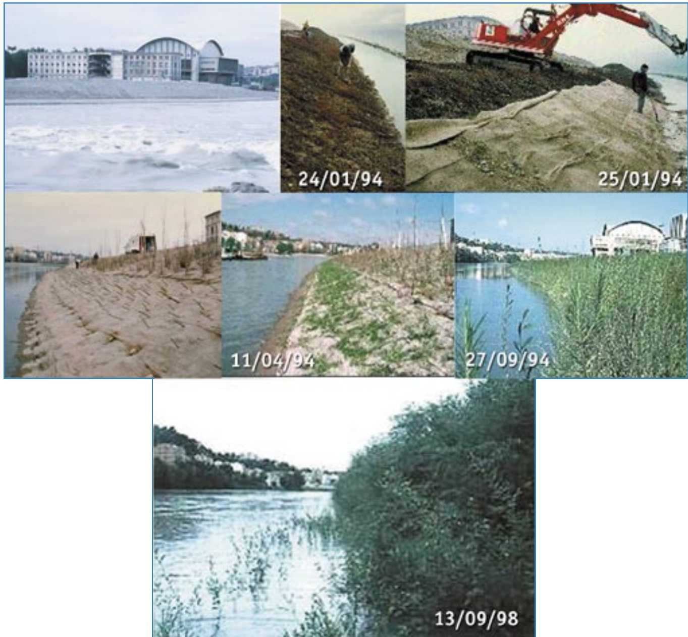
Foto 6 - Recuperação de margem do rio Ródano (Lyon)
