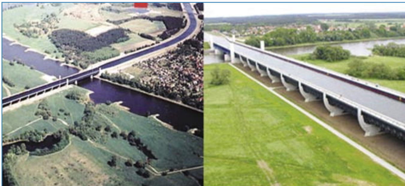
Foto 8 - Canal/Ponte sobre o rio Elba
