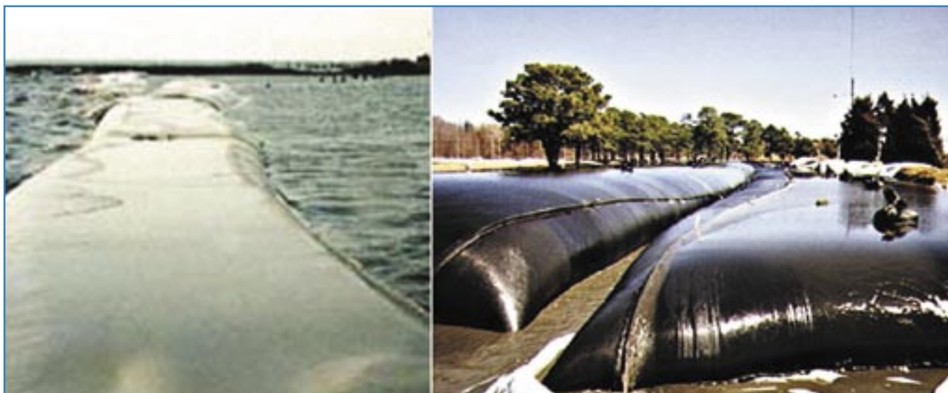
Foto 5 - Espigões construídos com tecido geotextil (geotubes)
