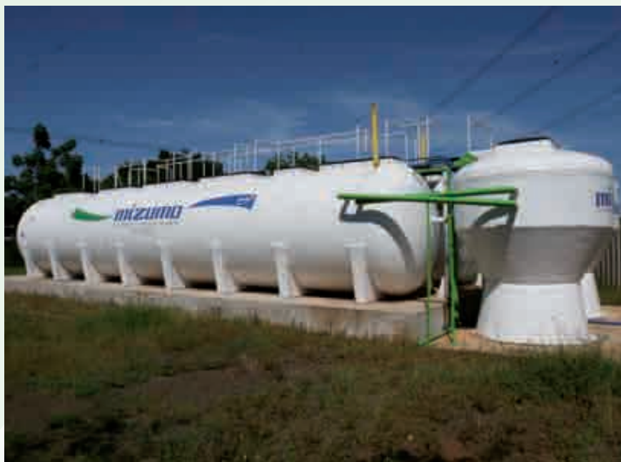
Melhoria da infra-estrutura de saneamento na região
