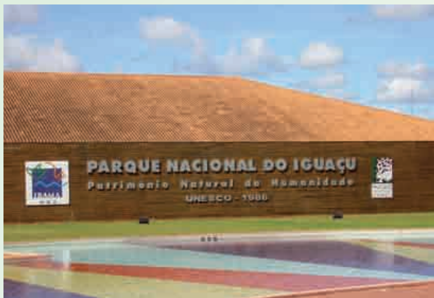
Vista parcial do Centro de Visitantes
