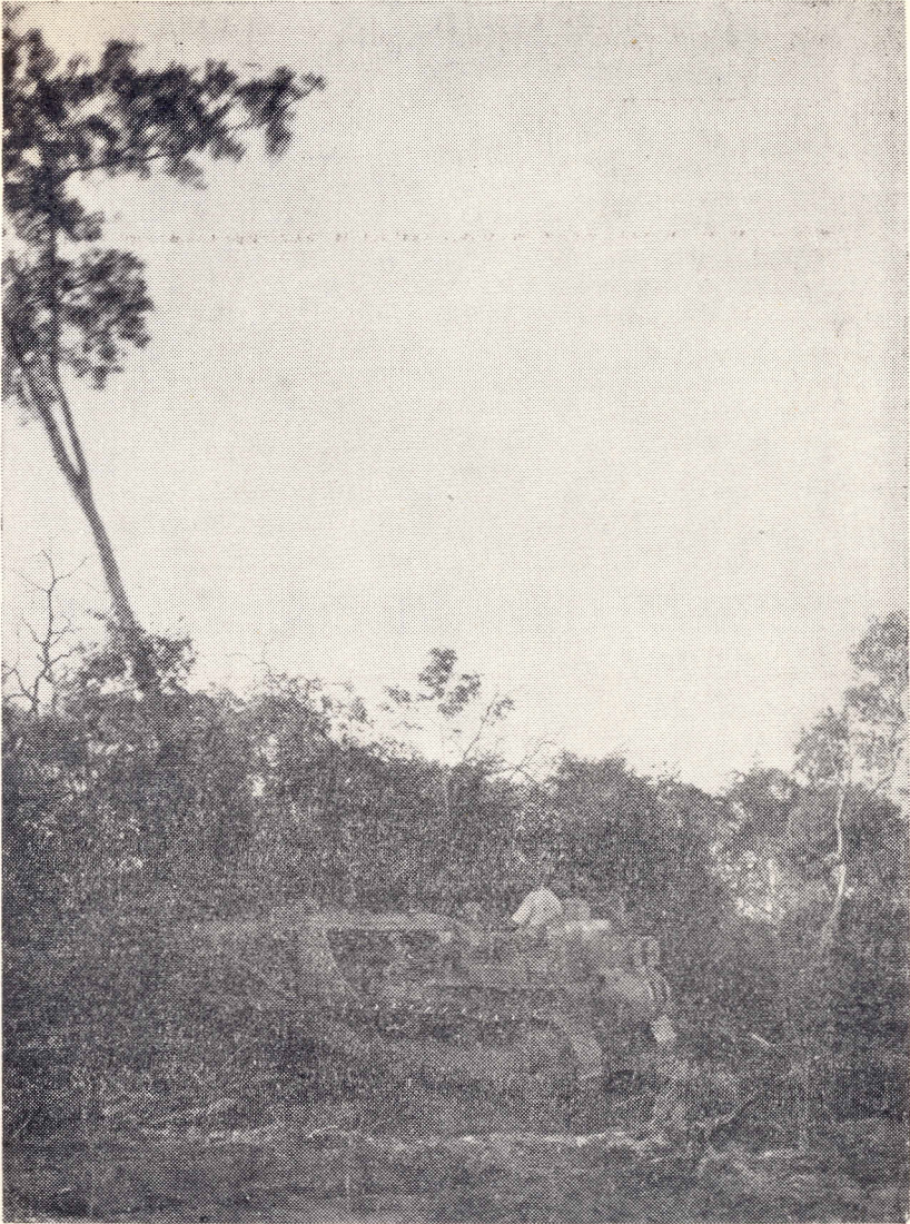
Fig. 76 — Operação de desmatamento, com trator.
