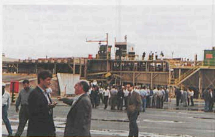
Aspecto das instalações, durante o ato inaugural.
