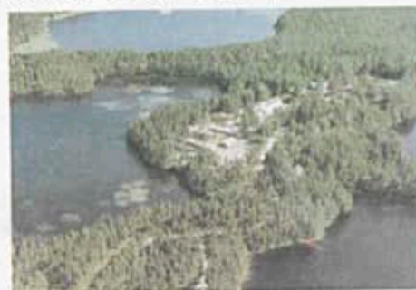
Instalações da Escola de Engenharia Florestal de Pieksämäki.
