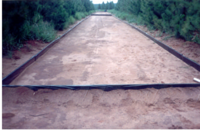
Figura 5 – Delimitação do segmento de estrada.
