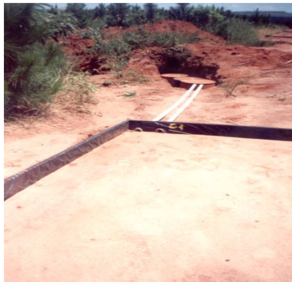
Figura 6 – Instalação dos tambores coletores.
