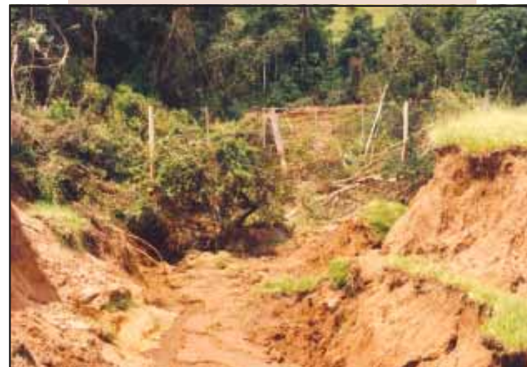
Remanescente florestal degradado pela erosão do solo.
