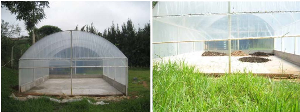
Figura 2.8 - Estufa para secagem do lodo. Vista geral (esquerda) e detalhe da cortina frontal aberta e do lodo no interior da estufa (direita).
