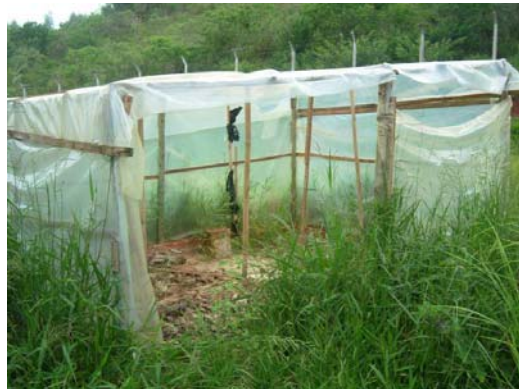
Figura 2.27- Vegetação com crescimento em direção ao interior da casa de lodo caledado.
