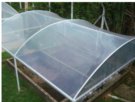
Figura 2.3 - Cobertura do leito de secagem, ETE Violeira, Viçosa-MG.
