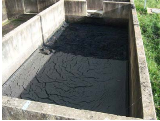
Figura 2.5 - Lodo remanescente (a ser enviado para estufa) sete dias após o descarte e após retirada de metade do lote para caleação.
