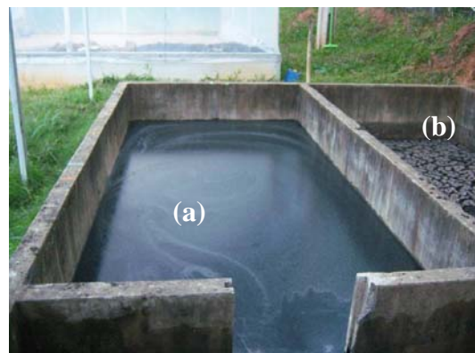
Figura 2.4 - Lodo no leito de secagem recém descartado (a) e após cerca de 15 dias (b), ETE Violeira, Viçosa-MG
