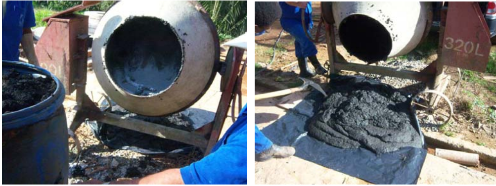
Figura 2.6 - Mistura do lodo com a cal em betoneira (esquerda) e lodo caleado logo após mistura (direita)
