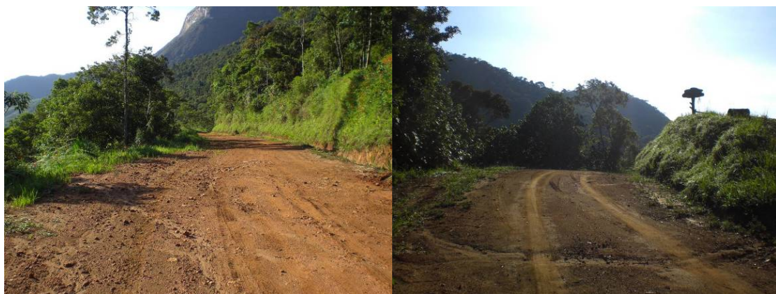
Figura 4 – Dois trechos da BR-482 dentro dos limites do Parque Estadual da Serra do Brigadeiro (PESB), MG.
