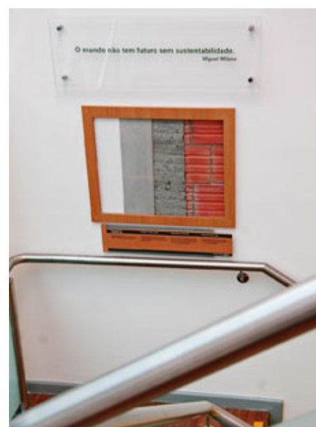
Figura 2.8. Na parede: tinta à base de água, revestimento com argamassa que não passou por processo de queima, cimento com mistura de resíduos de altos-fornos siderúrgicos. Fonte: Disponível em: < http://planetasustentavel.abril.com.br/noticia/cidade/conteudo_241689.shtml >. Acesso em: abr. 2008.
