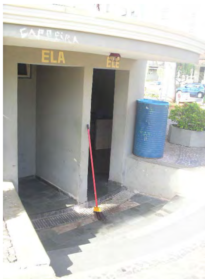
Figura 20 – Vista dos banheiros do Coreto. Fonte: Arquivo do autor, 2007.
