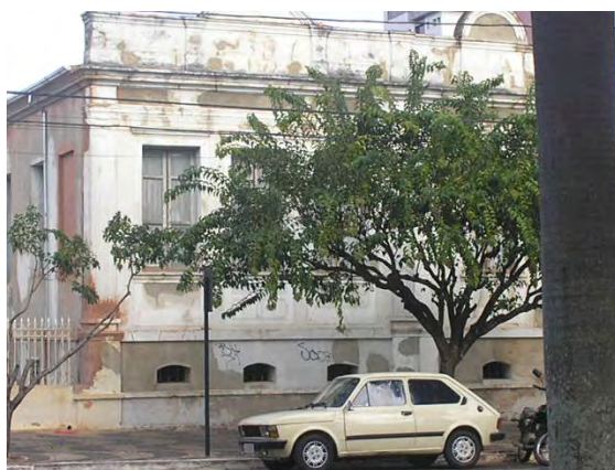
Figura 17 – Casa de Olegário Maciel (em restauração). Fonte: Arquivo do autor, 2007.
