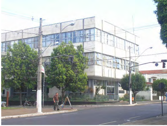
Figura 22 – Palácio dos Cristais (atual sede da Prefeitura). Fonte: Arquivo do autor, 2007.
