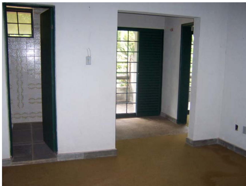
Foto 36: Interior de uma das suítes do hotel, ainda em bom estado de conservação.
