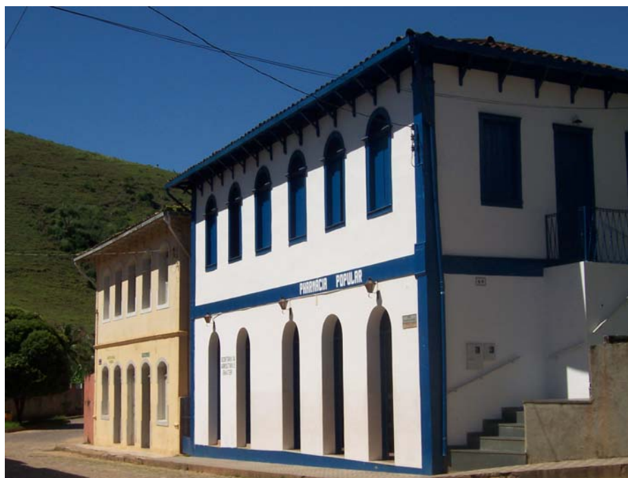
Foto 10: Vista de parte do patrimônio arquitetônico de Miradouro.
