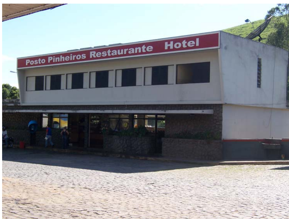
Foto 41: Fachada do Posto Pinheiros, Restaurante e Hotel.
