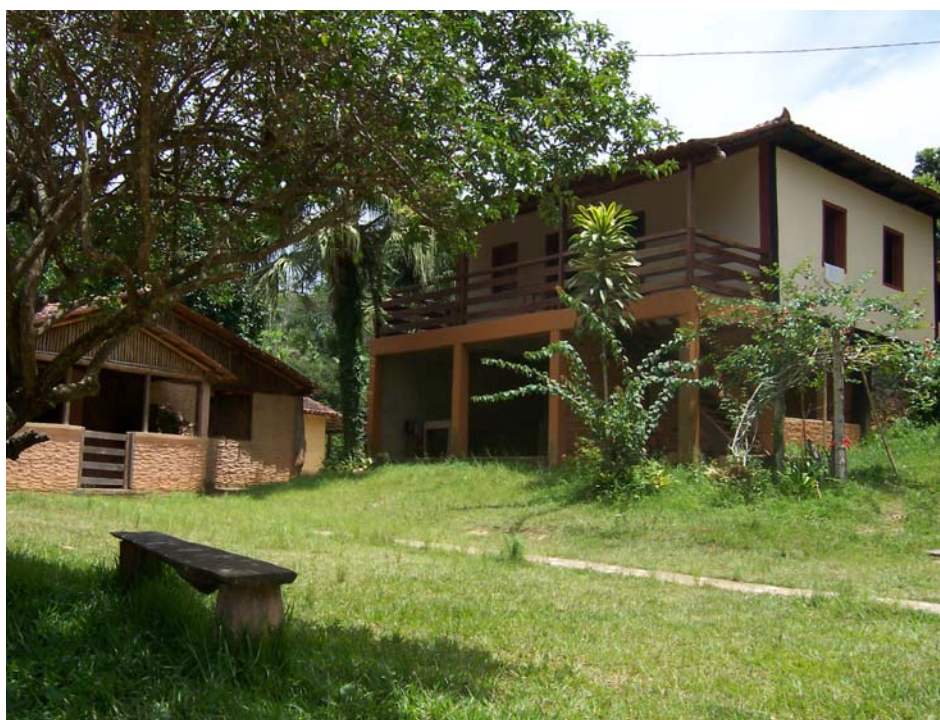
Foto 26: Casa sede e restaurante ao lado.
