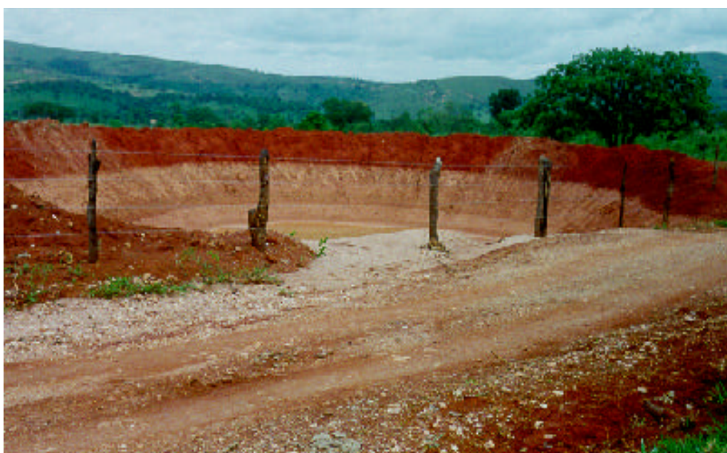
Figura 35: Reservatório de recepção de água de estrada.
