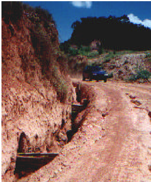
(a) - Contenção com bambu seco na beirada da estrada.
