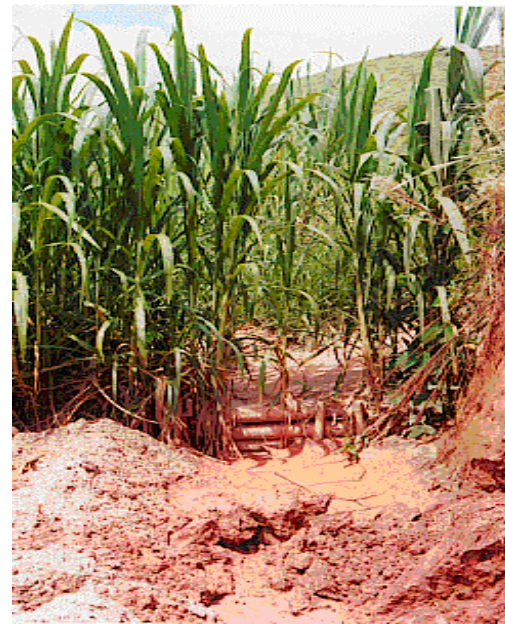
(b) - Contenção com material vivo.
