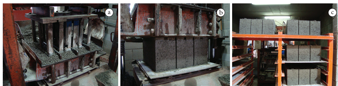
Figura 1. Produção de blocos protótipos: a) vibrocompactação do concreto; b) abertura dos extratores; c) cura dos blocos.
