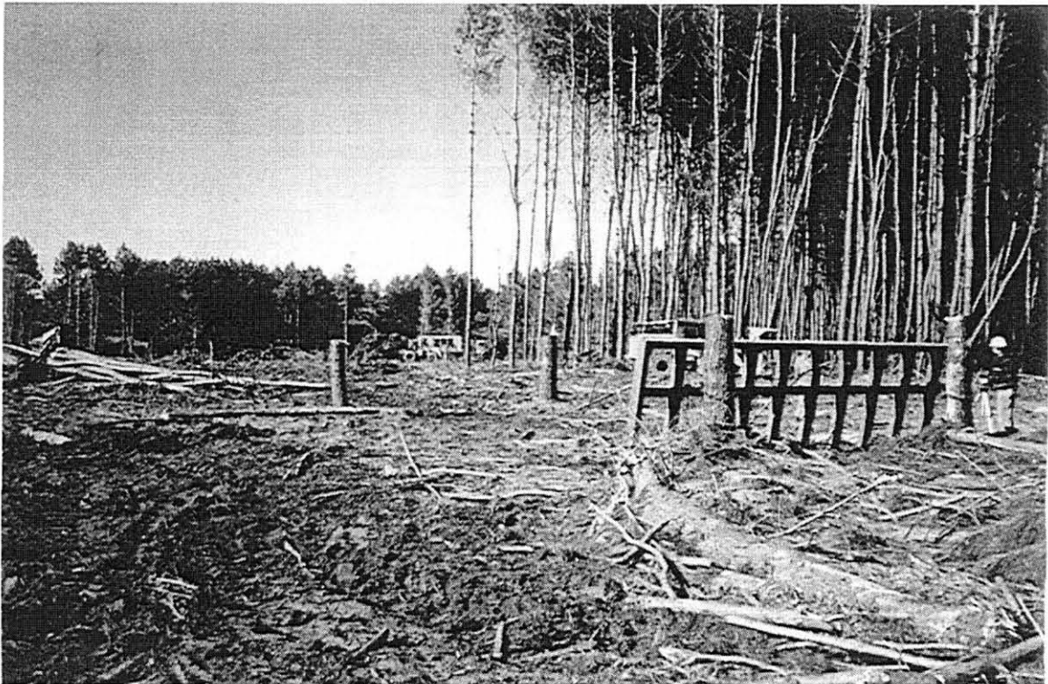
FIGURA 2 – DISPOSIÇÃO DA GRADE PARA OPERAÇÃO DE DESGALHAMENTO NA ÁREA DE GRADE:
