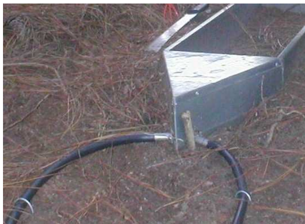
Figura 6. Encaixe das mangueiras flexíveis nos tubos metálicos.
