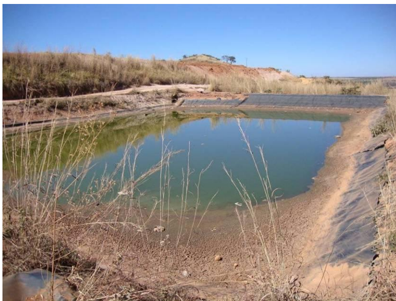
Figura 08 – Lagoa de chorume do Aterro Sanitário de Formosa, agosto de 2011. Vista de norte para sul.
