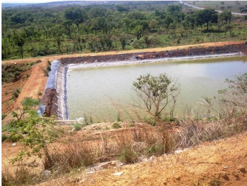
Figura 07 – Lagoa de chorume do Aterro Sanitário de Formosa, dezembro de 2010. Vista de leste para oeste.
