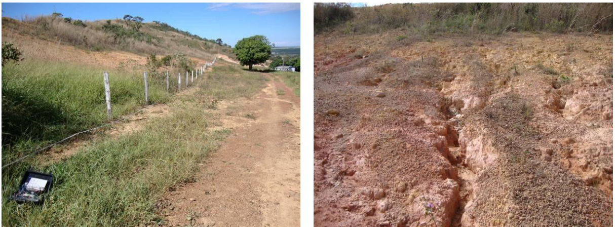
Figura 19 – Talude e erosão no talude inferior do Aterro Sanitário de Formosa.
