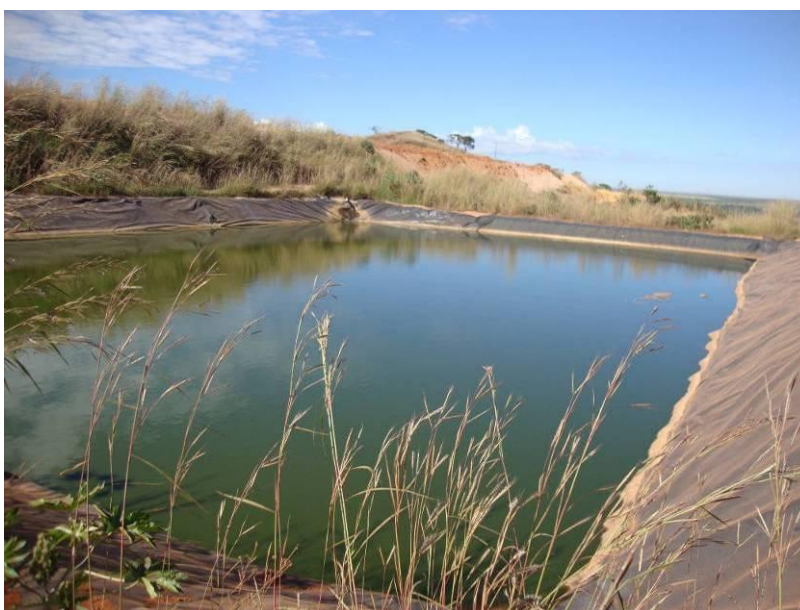
Figura 09 – Lagoa de chorume do Aterro Sanitário de Formosa, maio de 2012. Vista de norte para sul.
