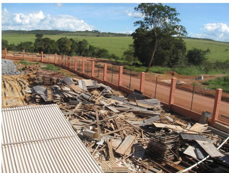
**Figura 7** - Resíduos acumulados, não segregados e armazenados em local inadequado.
