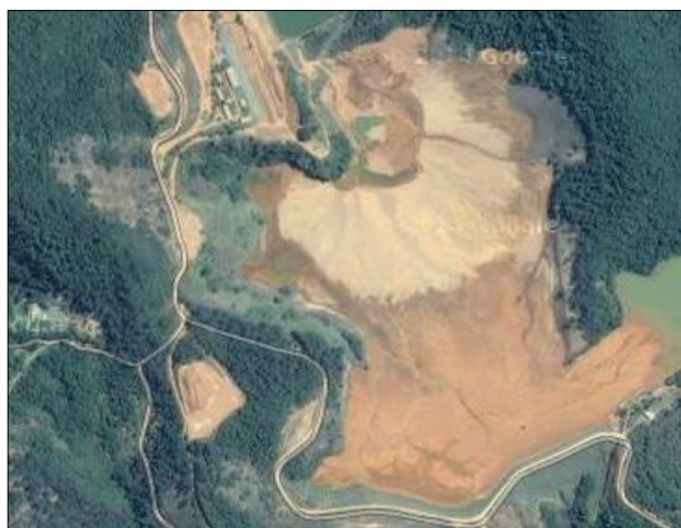
Figura 2. Barragem de rejeitos – Itamarati de Minas. Fonte: Dados Cartográficos. 2015. Google Earth.
