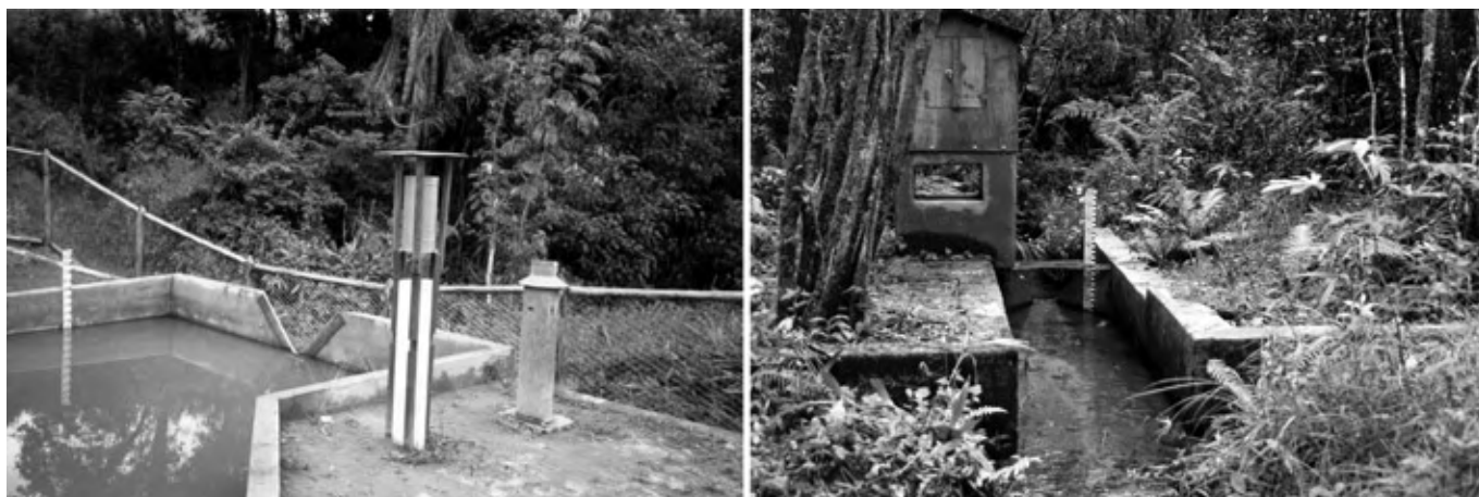
Figura 1. Os pioneiros: vertedor da microbacia de Santa Branca (esquerda) e de Itatinga (direita).
