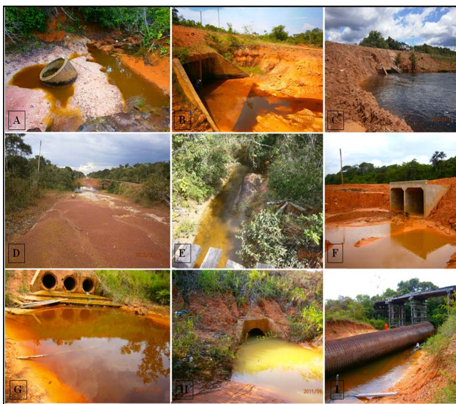
Figura 6. Situação presenciada nos pontos de coleta. A) Restos de obra no curso d'água; B) e C) solo exposto; D) ausência de vegetação na APP; E) bueiro metálico deixado no curso d'água; F) obra recente, solo exposto; G) bueiro elevado; H) bueiro semiafogado; I) bueiro sem uso abandonado no leito do curso d'água.
