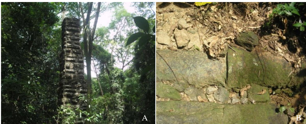
Figura 05. Resquícios de intervenção pela extinta Companhia Têxtil Brasil Industrial no PNMCP. A) Coluna construída em 1892 para sustentação da tubulação. B) Restos da tubulação utilizada.
