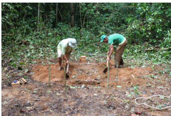
Figura 30 – Limpeza e marcação do terreno.
