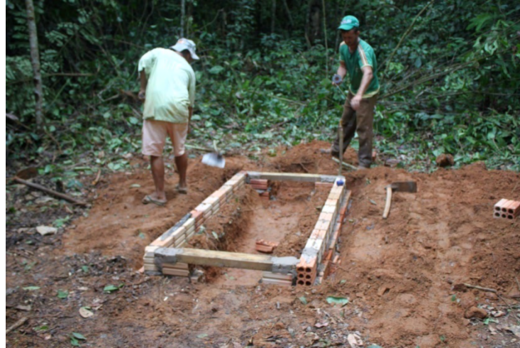
Figura 31 – Início da execução da construção em alvenaria.
