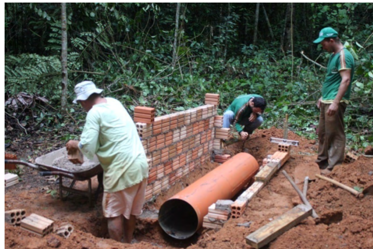
Figura 32 – Instalação do trocador de calor e execução da alvenaria.
