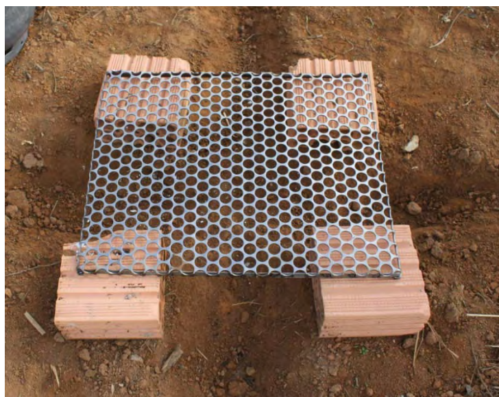
Figura 12 – Base elevada para instalação do reator.
