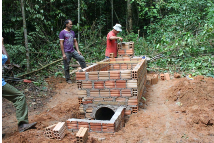
Figura 34 – Execução da construção da chaminé e detalhe da fornalha.
