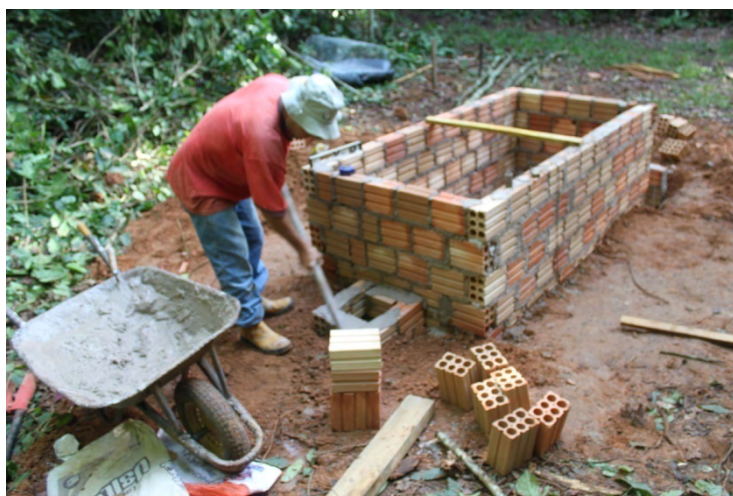
Figura 33 – Finalização da câmara plenum e detalhe da abertura para a chaminé.
