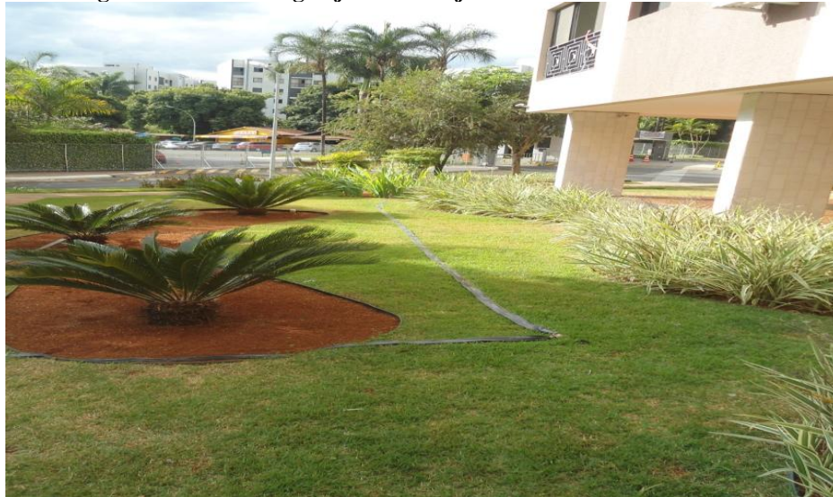
Figura 7: Sistema de gotejamento no jardim do Edifício do bloco A.
