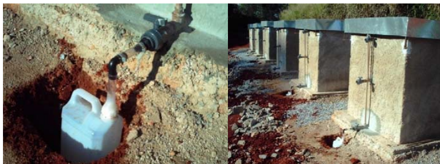
Figura 5 Células experimentais providas de sistemas de controle de fluxo, armazenamento de líquidos e sistema de cobertura em Lavras - MG.
