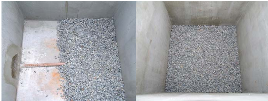
Figura 4 Leito filtrante e sistema de drenagem de líquidos instalados na base das células experimentais em Lavras - MG.
