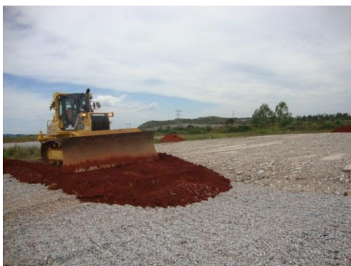
Fotografia 3. Instalação das camadas selantes (20 cm) formadas por substrato B1 ou solo compactados.
