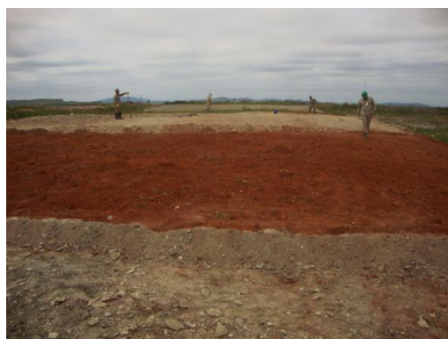
Fotografia 4. Instalação das camadas de cobertura (20 cm) formadas por substrato B1 ou solo sem compactação.
