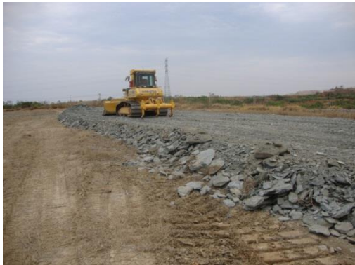
Fotografia 1. Montagem da camada de substrato B2 (50 cm) na base do experimento.
