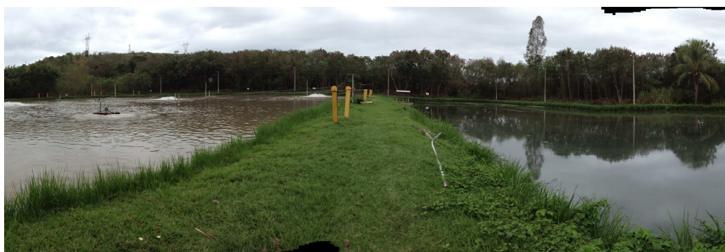
Figura 8 – Vista da lagoa de aeração e lagoa de decantação escura
