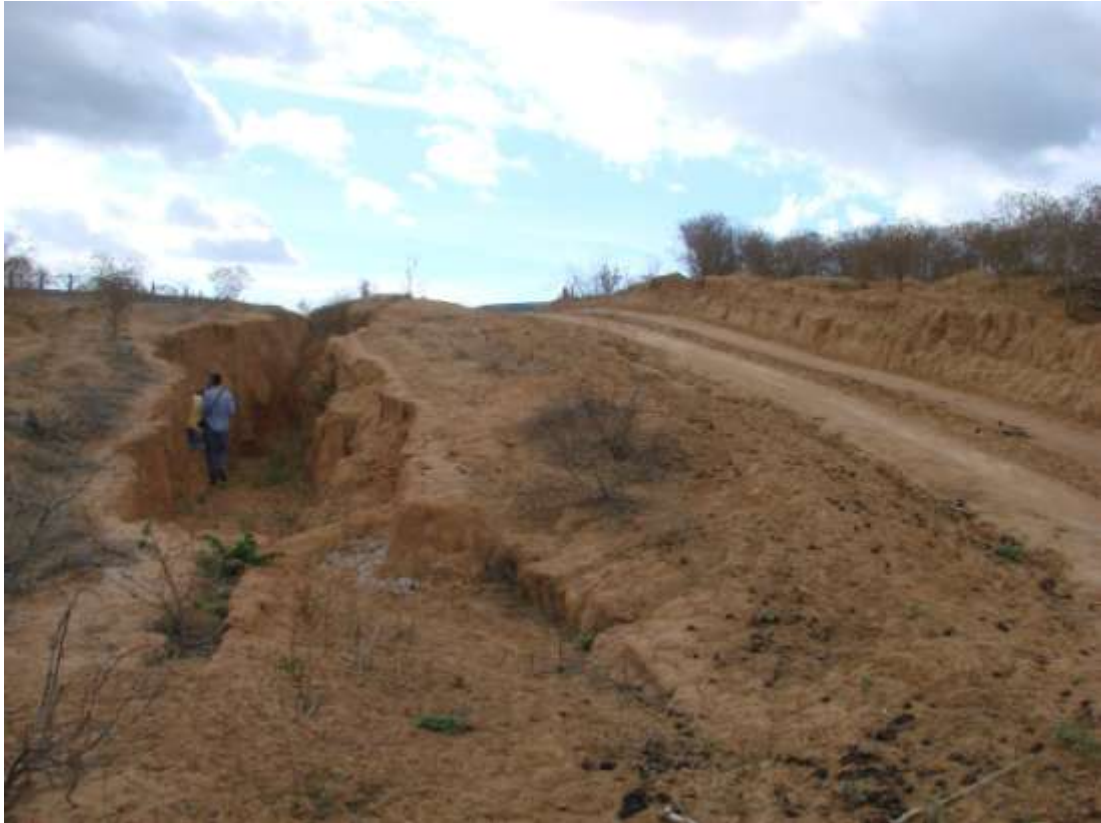
Figura 76: Processo erosivo de grandes proporções no Ambiente 10
