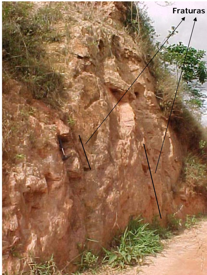
Foto 06 – Vista geral do corte da estrada em que se pode observar a rocha extremamente alterada e as principais estruturas geológicas existentes no maciço (foliação e fratura sub-vertical).
