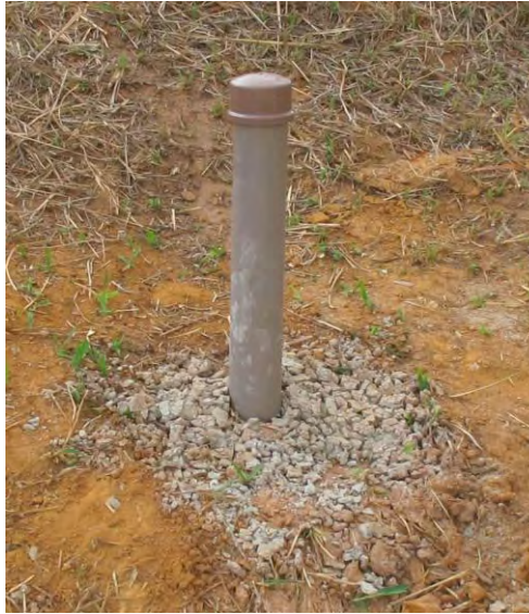
Figura 24: Detalhe de poço instalado na microbacia.
