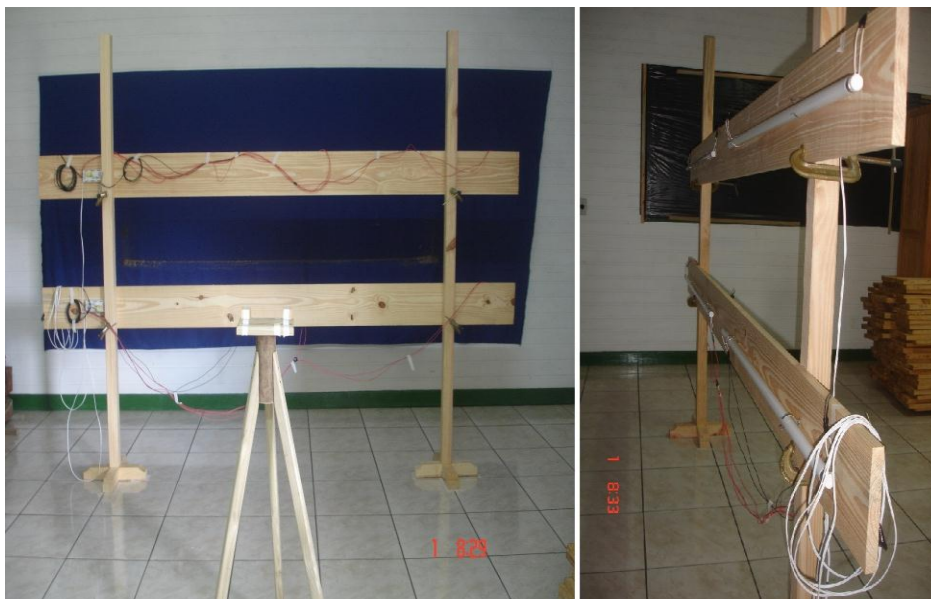
Figura 18 – Estrutura construída e instalada no ambiente de aquisição de imagens, para suporte e fixação da iluminação artificial.
