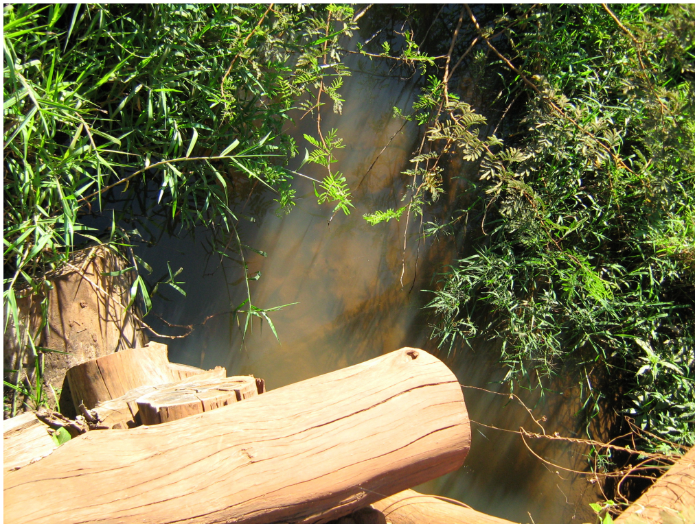
Figura 6 - Ponte da estrada do Loteamento Boa Esperança (P 5 )
