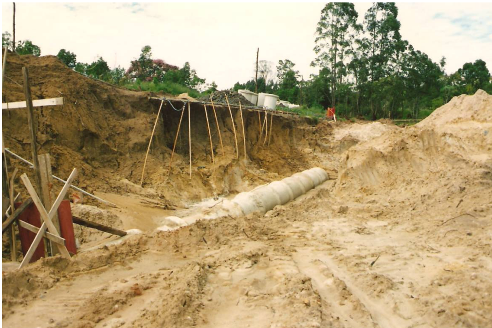
Foto 10 – Construção da ETE - SABESP e canalização da nascente no P 2
