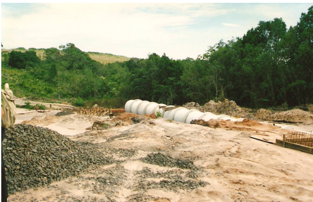
Foto 11 - Construção da ETE – SABESP e canalização da nascente no P 2
