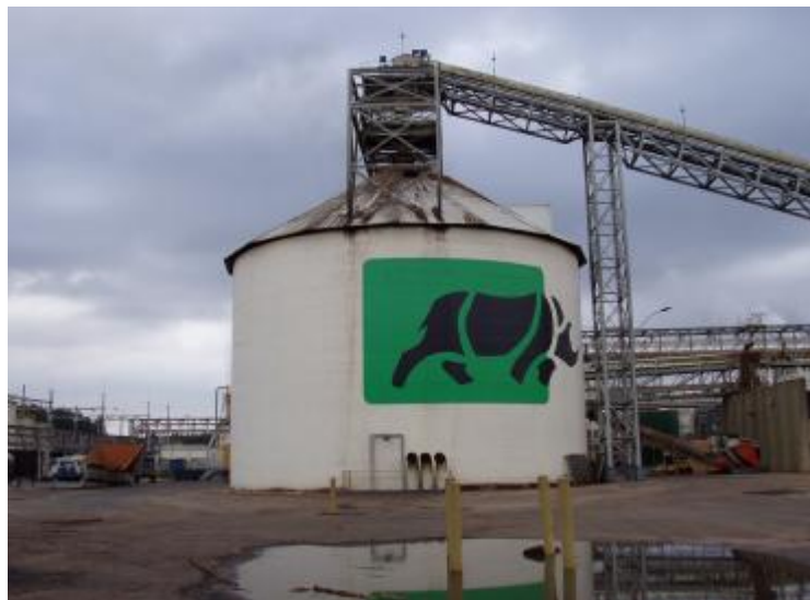
Figura 2.12: Pátio de cavacos em silos. Fonte: Duratex S.A. (2006).
