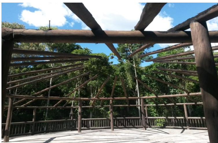
Figura 7: Telhado do centro de educação ambiental, Fonte: Victor Andrade, 2014.
