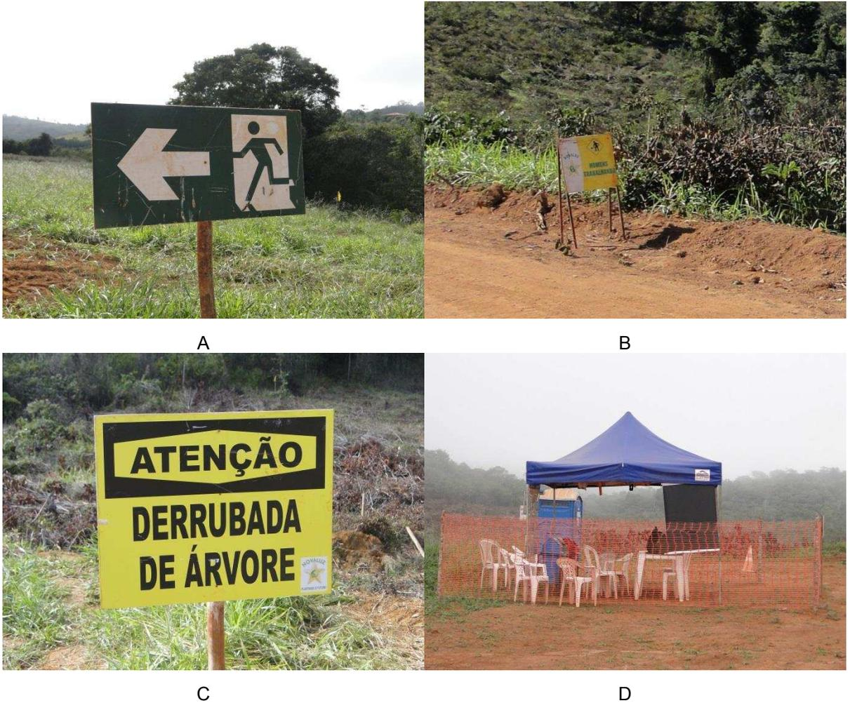
Figura 7- Placas de sinalização da área de supressão. A: rota de fuga. B: Homens trabalhando. C: Derrubada de árvore. D: ponto de apoio.
