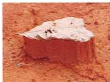
Proteção contra a desagregação do solo.
