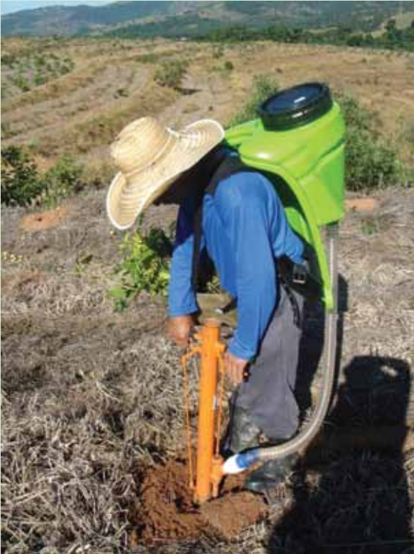
Figura 6.51: Aplicação do hidrogel através de equipamento costal, Fazenda Guariroba, Campinas, SP.
