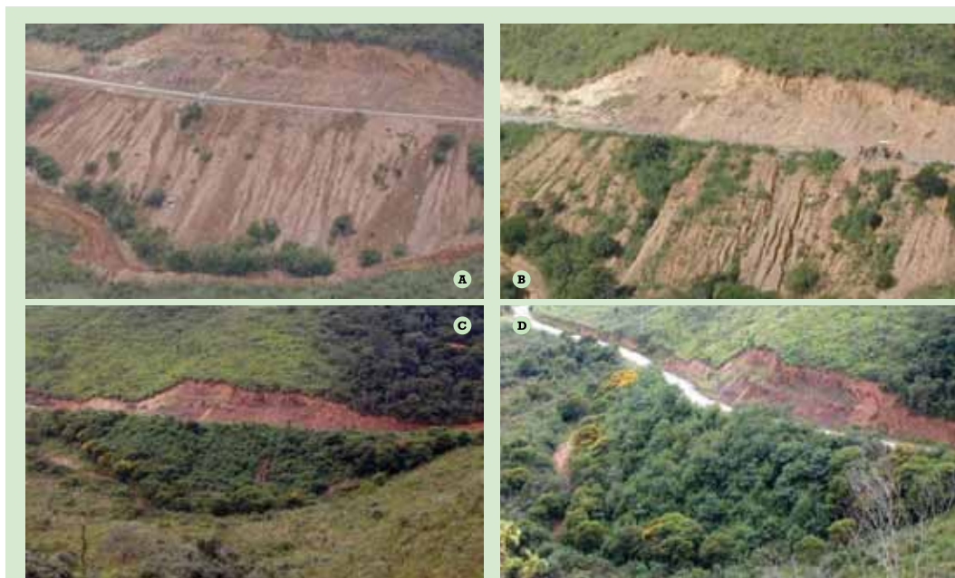
Figura 2.28: Processo de desenvolvimento da vegetação nativa em talude recuperado pela transferência de banco de sementes alóctone - talude antes da transferência (A), vista do talude depois de 3 meses (B), 9 meses (C) e 14 meses (D).
