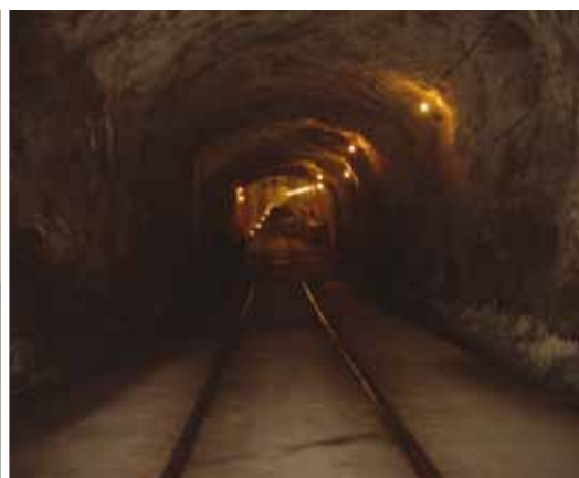
PARTE SUBTERRÂNEA DA USINA HENRY BORDEN. Borden. Fonte: EMAE.
