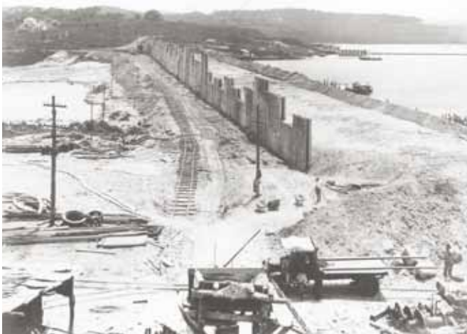
BARRAGEM RIO GRANDE – DÉCADA DE 30. Fonte: Fundação de Saneamento e Energia.
