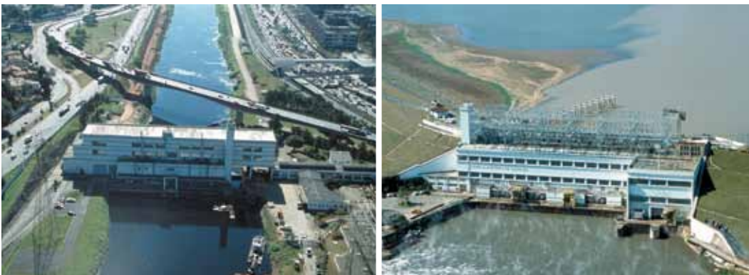
USINAS ELEVATÓRIAS DE TRAIÇÃO (ESQUERDA) E PEDREIRA (DIREITA). Fonte: Empresa Metropolitana de Águas e Energia – EMAE.
