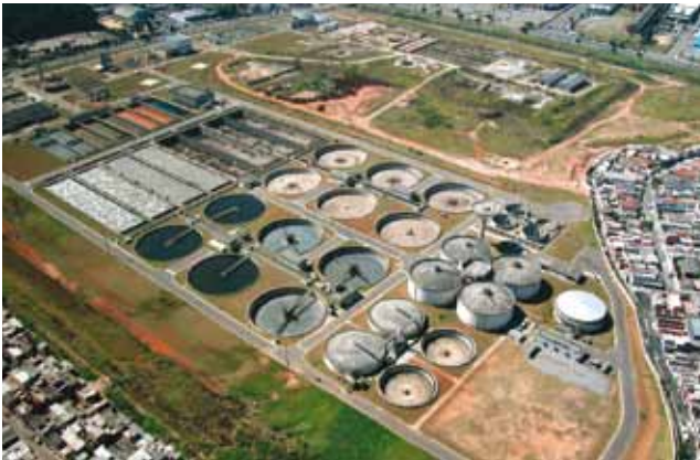
ESTAÇÃO DE TRATAMENTO DE ESGOTO (ETE) ABC. Fonte: Sabesp.
