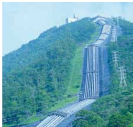
PARTE EXTERNA DA USINA HENRY BORDEN. Fonte: EMAE.
