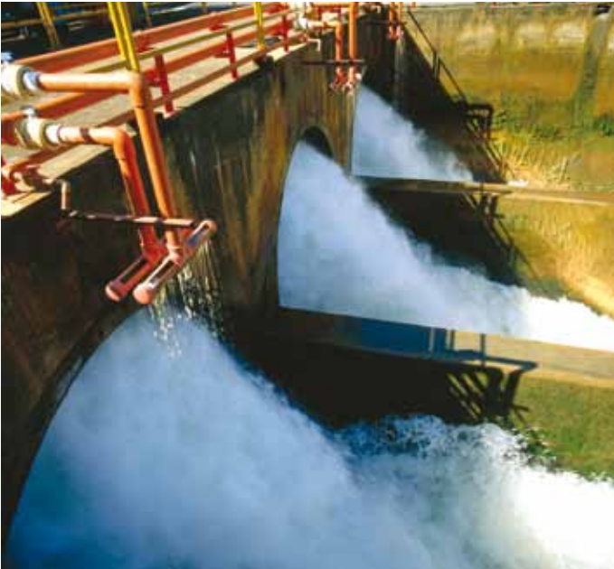
CHEGADA DA ÁGUA NA ESTAÇÃO DE TRATAMENTO. Fonte: Sabesp.
