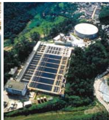
ESTAÇÃO DE TRATAMENTO DE ÁGUA (ETA) RIO GRANDE.
