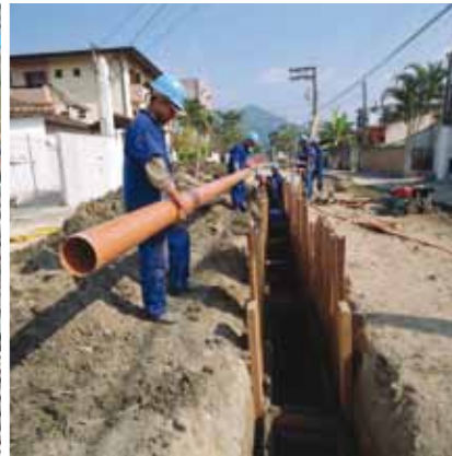
LIGAÇÃO DE REDE COLETORA DE ESGOTO. Fonte: Sabesp.
