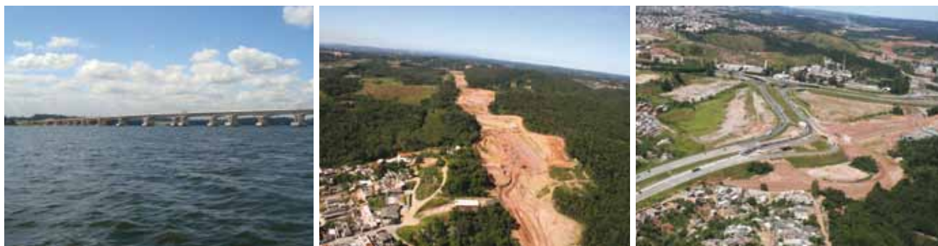
TRECHOS DO RODOANEL TRECHO-SUL. Fonte: SMA.
