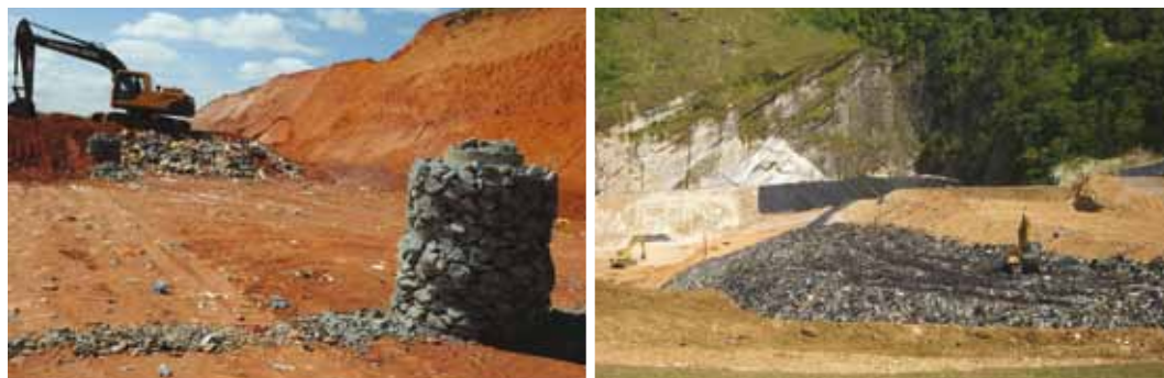
ATERRO SANITÁRIO: FORMA ADEQUADA DE DISPOSIÇÃO FINAL DE RESÍDUOS SÓLIDOS. NA FOTO À DIREITA PODE-SE OBSERVAR A MANTA DE IMPERMEABILIZAÇÃO, QUE IMPEDE A INFILTRAÇÃO DO CHORUME NO SOLO E A CONTAMINAÇÃO DAS ÁGUAS SUBTERRÂNEAS. Fonte: SMA.
