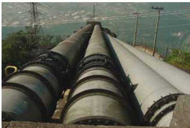
FOTO ATUAL DOS DUTOS POR ONDE DESCE A ÁGUA PROVINDA DO RESERVATÓRIO RIO DAS PEDRAS, GERANDO ENERGIA. Fonte: EMAE.
