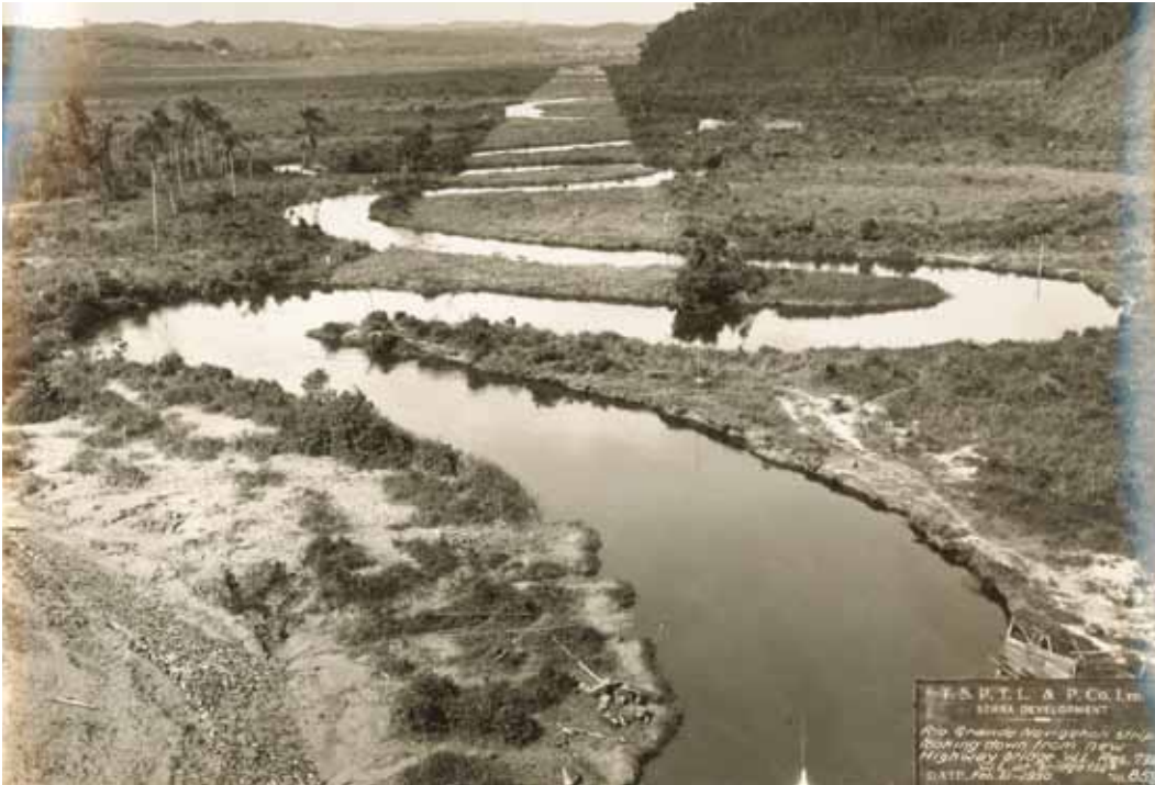
RIO PINHEIROS, 1930. Fonte: Fundação de Saneamento e Energia.
