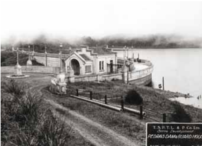
BARRAGEM RIO DAS PEDRAS – 1932. Fonte: Fundação de Saneamento e Energia.
