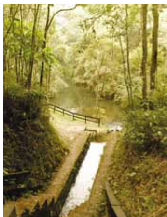
DUTOS DE ÁGUA.
