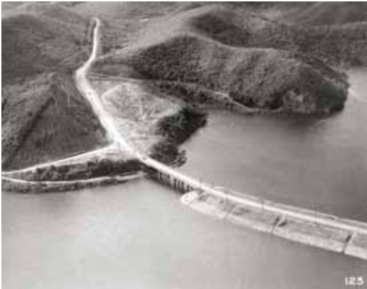
PONTE DA RODOVIA ANCHIETA SOBRE A REPRESA BILLINGS – DÉCADA DE 50.
